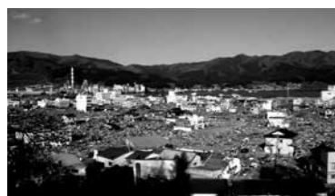
震災直後の大船渡市中心街。コンクリートの建物以外はほとんど破壊された。
