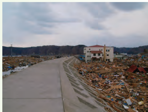
2011.3.11 東日本大震災による被災状況 (宮古・田老地区)
